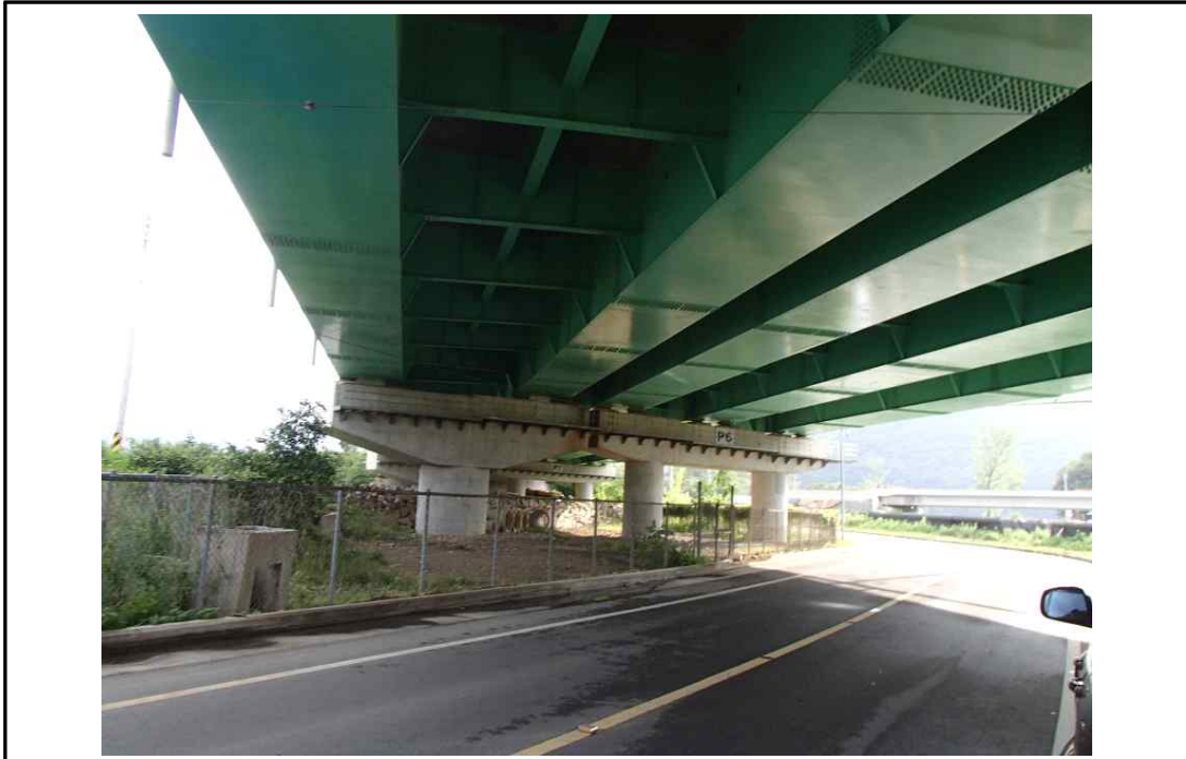
Steel Box Girder 외부 전경
