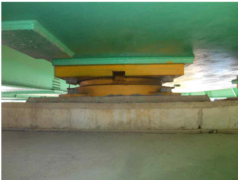
받침장치 전경 (가동단)
