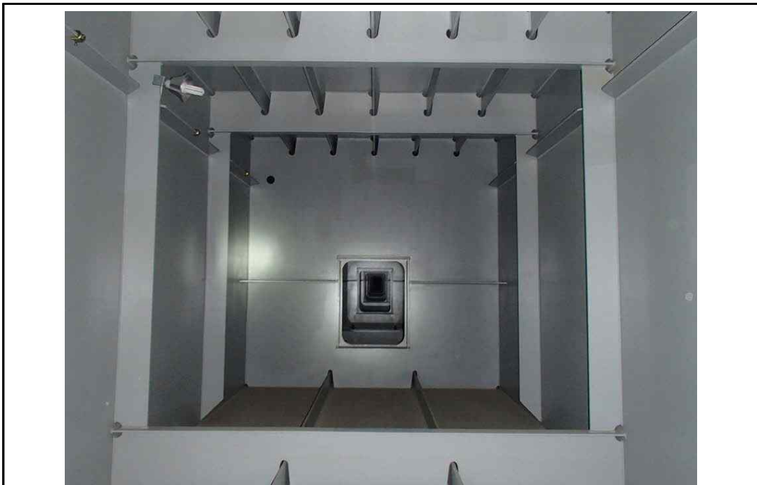
Steel Box Girder 내부 전경
