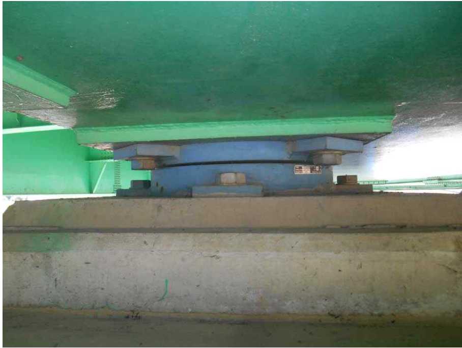
받침장치 전경 (고정단)
